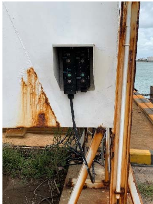
รูปที่ 3-32 Ammonia Detector บริเวณ Loading Arm
