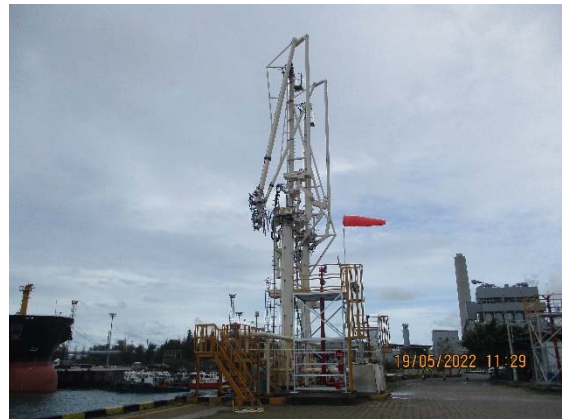
รูปที่ 3-2 Loading Arm แบบ Flexible Hose ทำงานด้วยระบบ Hydraulic
