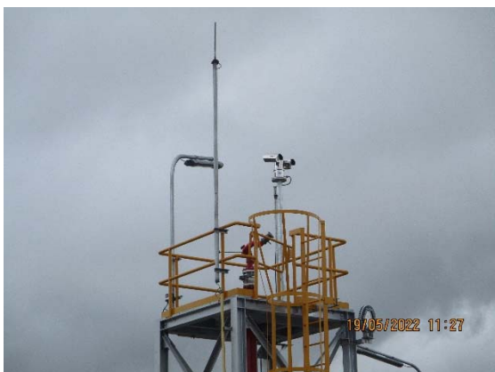
รูปที่ 3-35 Fix Monitor (หัวฉีดน้ำดับเพลิงบริเวณหน้าท่า)
